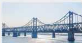
Zone de pont
